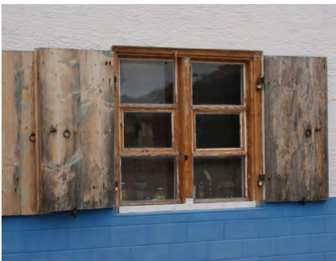
Typisches Holzfenster mit Holzfensterläden
