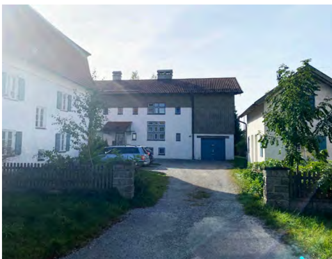
wasserdurchlässiger Boden, lockere Pflasterung und Rasengittersteine beim Pfarrhof
