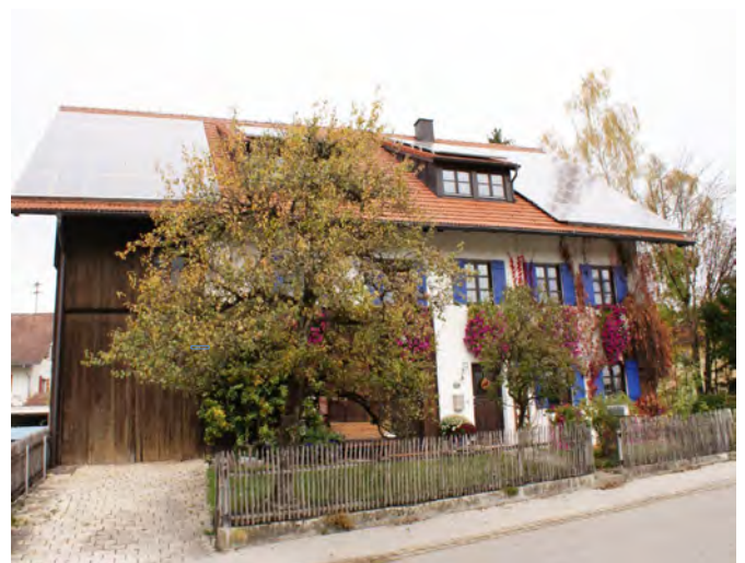
Ortstypischer Hofbaum und Fassadenbegrünung
