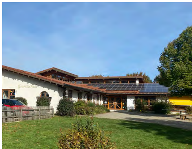
genutztes Dachflächenpotential für PV-Anlage / Grundschule
